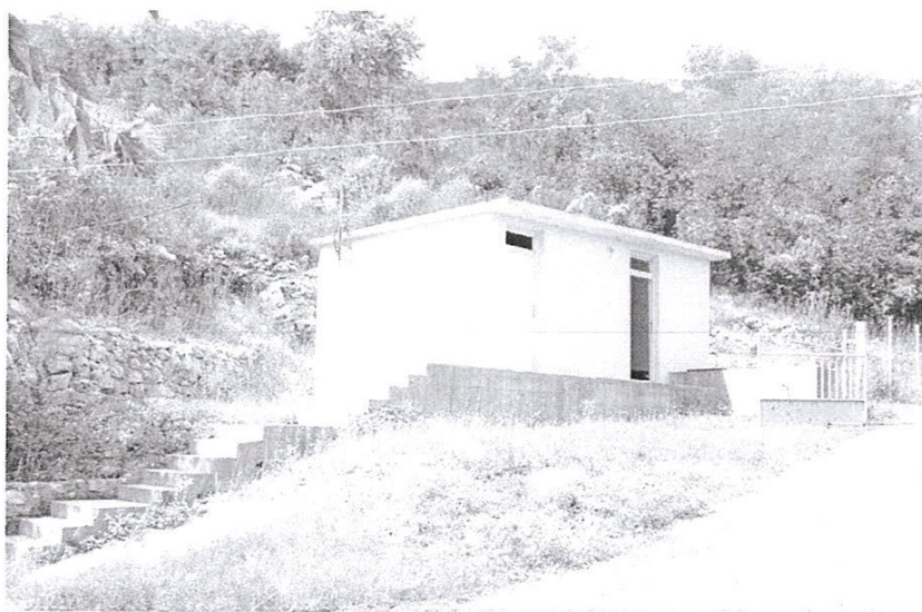
Pumpna stanica Oraška jama – novi pogon
